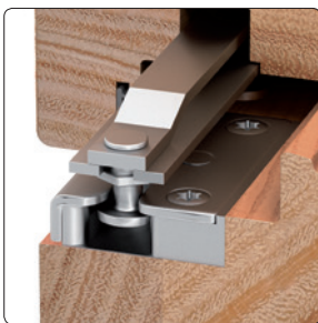
PaXoptima78 in PaXsecura 300 mit durchwurfhemmender Verglasung P5A
